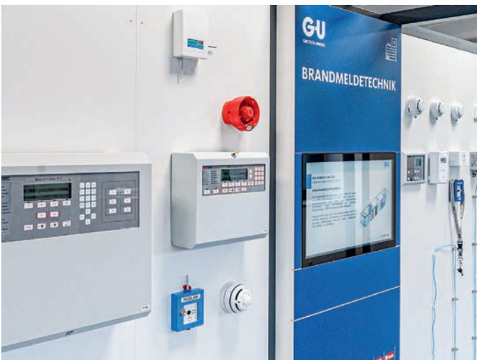
Brandmeldetechnik trägt frühzeitig zur Sicherung der Fluchtwege bei.
