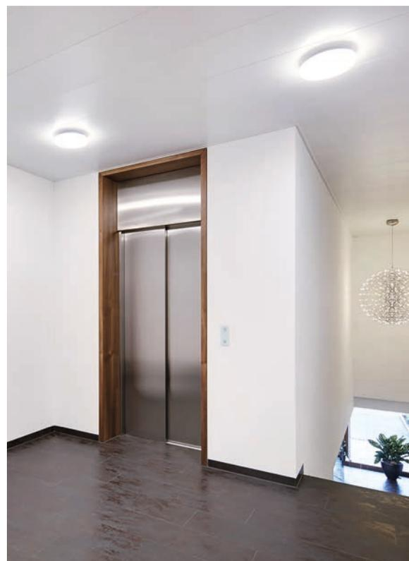
Schon das alleinige Blockfutter gibt der Maueröffnung zum Lift eine edle Fassung, mit sockelbündigem Abschluss.
