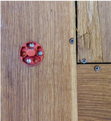
Einhängebeschläge ermöglichen dem Doppel eine gewisse Bewegung, fixieren aber auch die Mitte.
