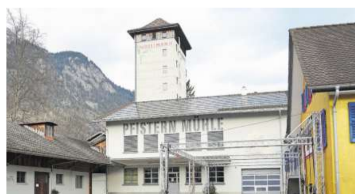
Die Pfisternmühle soll einer Überbauung weichen.
