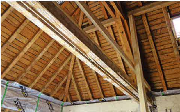
Der alte Dachstuhl wurde, wo nötig, mit neuen Stützen und Balken verstärkt.
