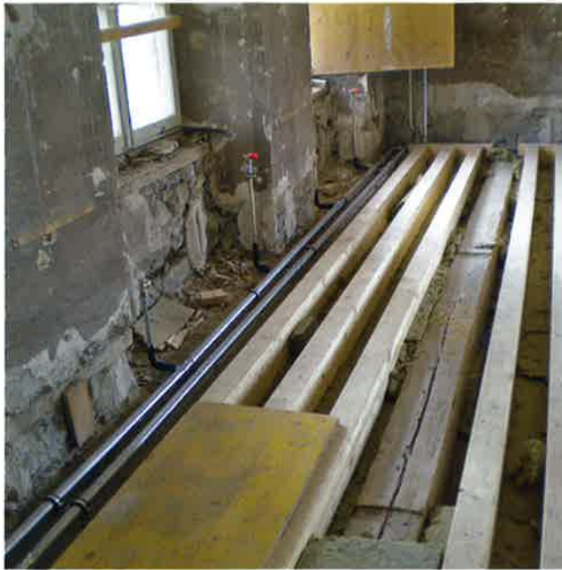
Hier wird das Tragwerk in zukünftigen Schulzimmern montiert.
