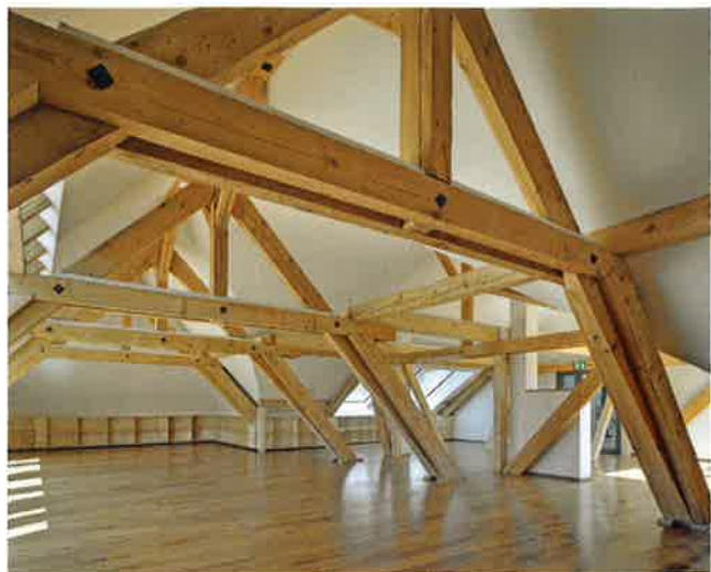
Das ehemalige Estrichgeschoss wurde zu einem modernen Lernraum ausgebaut.
