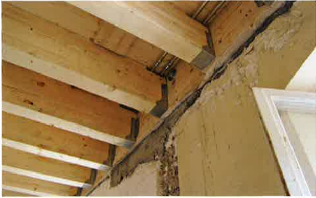
Mit Stahlschuhen wurden die Träger der Rippendecke befestigt.
