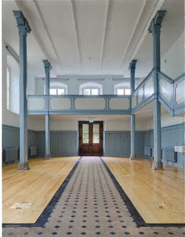
In der ehemaligen Kapelle findet sich eine Raumhöhe von 5,3 Meter. Hier tragen zwei Unterzüge die Lasten aus der Decke über Holzstützen ab.
