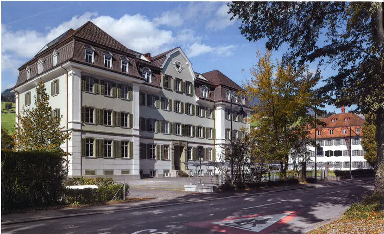
Das Konviktsgebäude wurde 1868 eröffnet und steht an der Brünigstrasse mitten im Sarner Bildungsbezirk.
