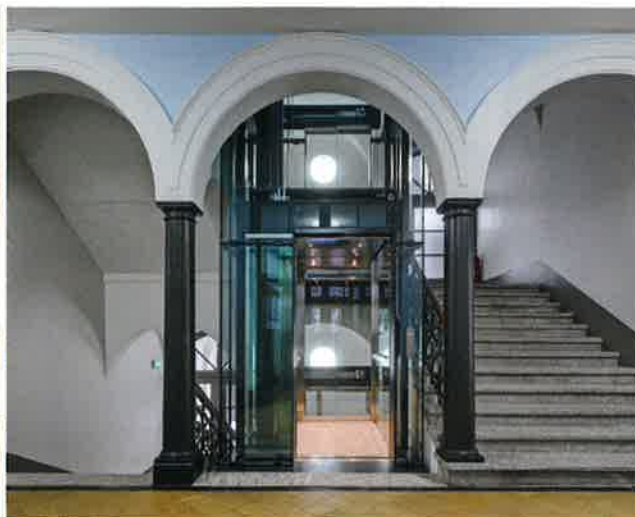
Einzig das nachträglich gebaute Treppenhaus von 1898 ist in Massivbauweise ausgebildet.
