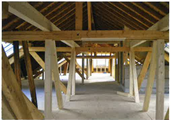
Die verstärkte Dachgeschosskonstruktion steht zum Ausbau bereit.
